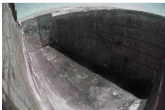
Slika 6. Prazna posuda za odlaganje otpada.
