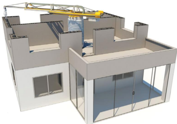
Рисунок 2. Печать стен второго этажа здания.
