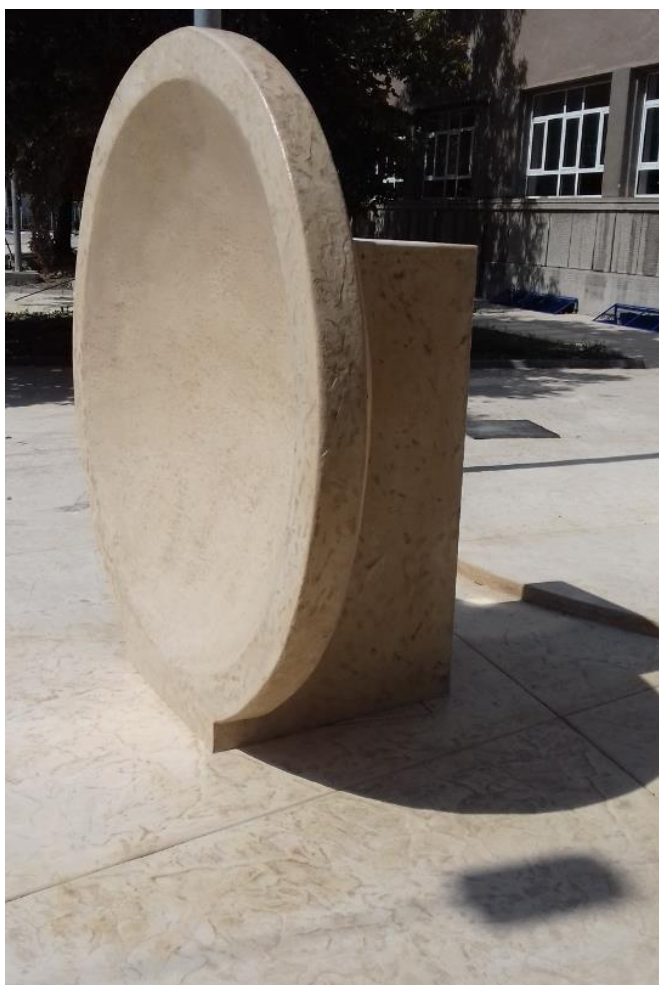
Slika 6. Akustički reflektor – praktična realizacija.
