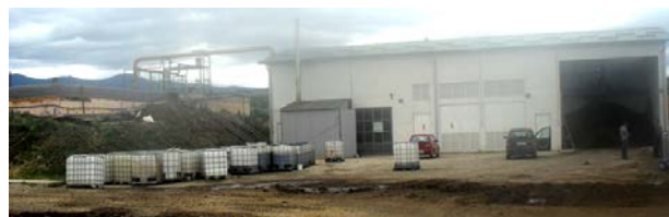
Slika 2. Postrojenje elektrane na biogas
