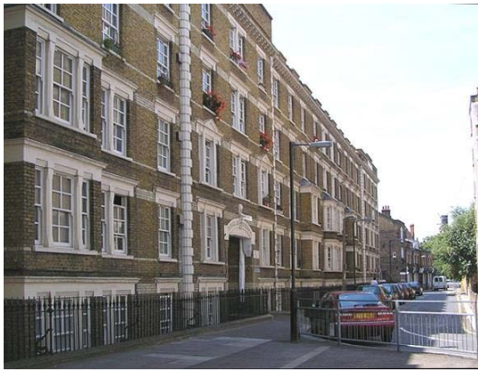
Slika 3. Daglas zgrade, fasada prema ulici.
