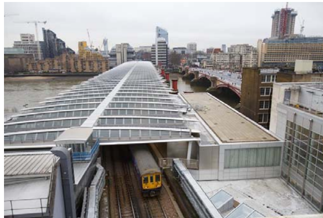
Slika 4. Integracija solarnih panela na železničkom depou.
