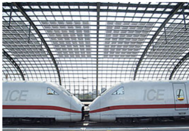
Slika 3. Solarni paneli integrisani u krov železničke stanice.
