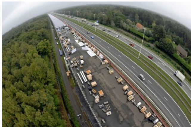
Slika 1. Postavljanje panela na tunelu na liniji Pariz – Amsterdam.
