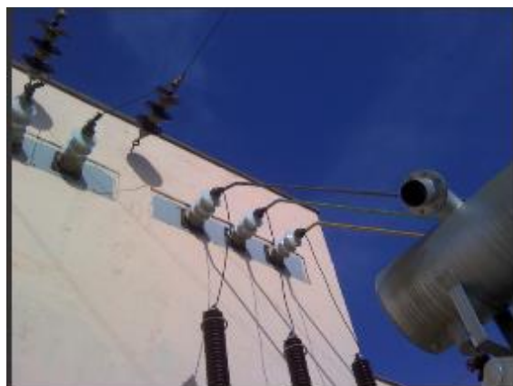
Slika 4. Realni prikaz katodnih odvodnika za napon od 35 000V
