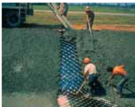
Slika 4. Zaštita kosina nasipa i rovova
