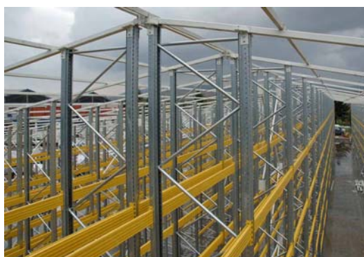
Slika 2. Čelična konstrukcija visokoregalnog skladišta.
