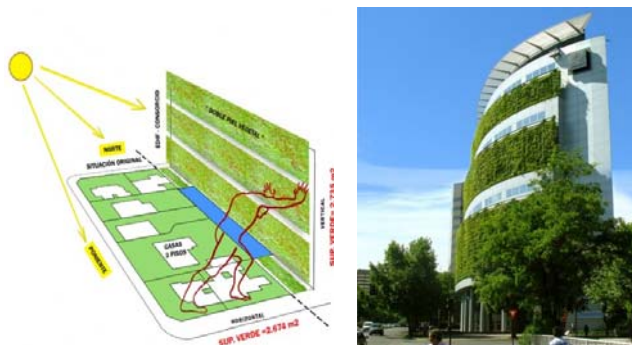
Slika 4. Edificio Consorcio, Santiago, Čile
