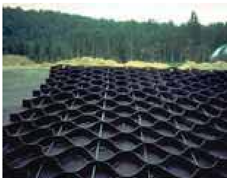
Slika 3. Perforirani čelijski zidovi za stabilnost kosina i kanala.
