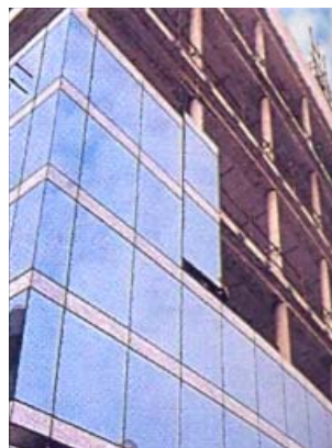
Slika 5. Montaža panela na objektu
